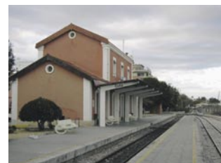
Estación de Gata de Gorgos.
