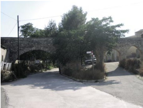
Acueducto en Cases del Senyor.
