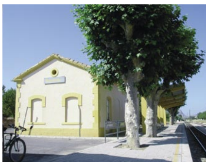
Estación de Benissa.
