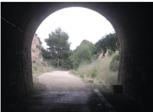
Túnel en la Vía Verde del Maigmó.
